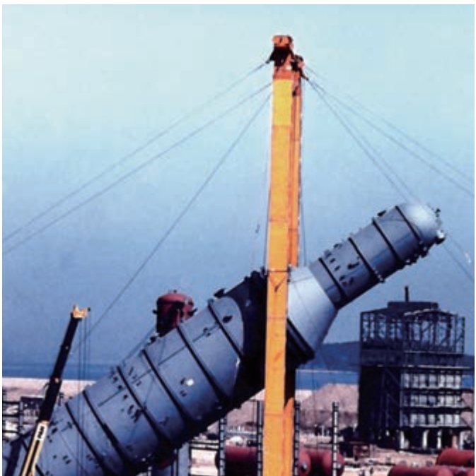
감압증류탑 설치 공사
