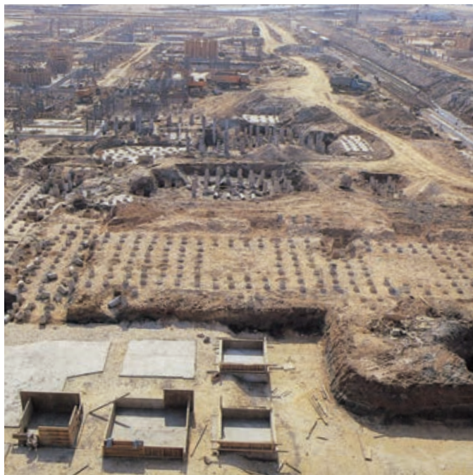
지반강화, 콘크리트 공사
