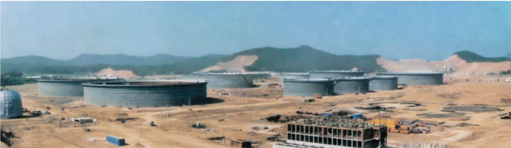
1987년 원유탱크 등 중량물 설치공사가 한창 진행 중인 대산공장
